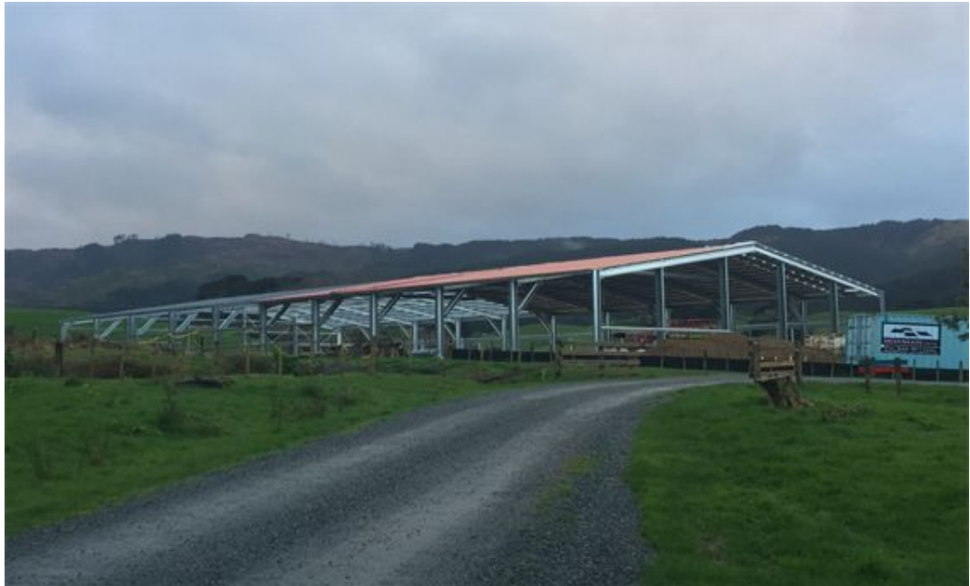
RDA arena progress
